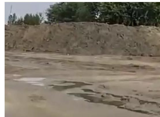
项目西侧空地
